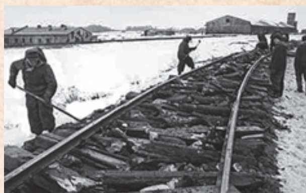
Восстановление разрушенных железнодорожных путей
